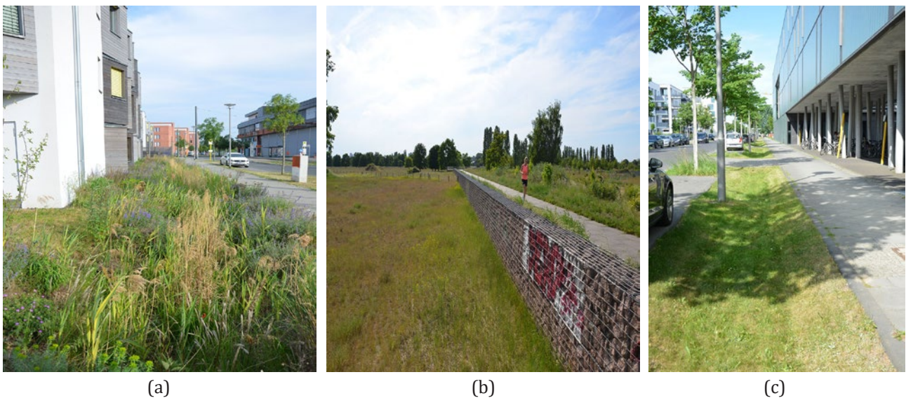
Figura 5: (a) Uso di trincee vegetate ai fini adattivi ed estetici. Fonte: Dell'Acqua (2018). (b) Landschafts Johannisthal Park. Fonte: Dell'Acqua (2018). (c) Uso di trincee a cielo aperto ai fini adattivi. Fonte: Dell'Acqua (2018).
